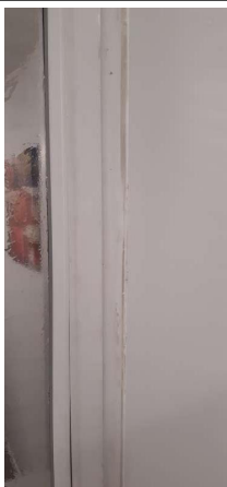
Prélèvement - P008 : RDC / Bureaux administratifs / n°15 - Mastic- (Absence d'amiante)
