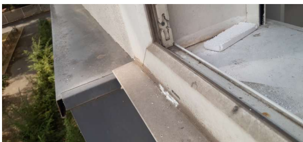
Prélèvement - P020 : Extérieur / Façades - Mastic- (Absence d'amiante)
