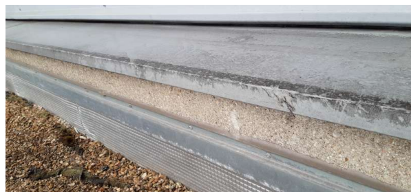
Prélèvement - P061 : Extérieur / Toiture terrasse - Enduit- (Absence d'amiante)
