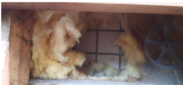
Déclaré - : Extérieur / Façades - Isolant sous bardage- (Absence d'amiante)
