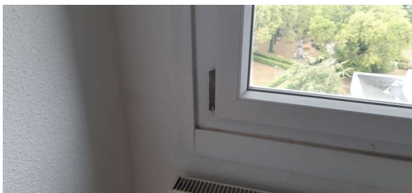
Prélèvement - P046 : R+9 / 907 - Bande calicot- (Absence d'amiante)
