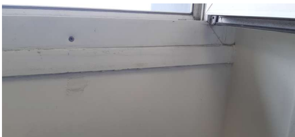
Prélèvement - P036 : R+6 / Cuisine - Enduit- (Absence d'amiante)
