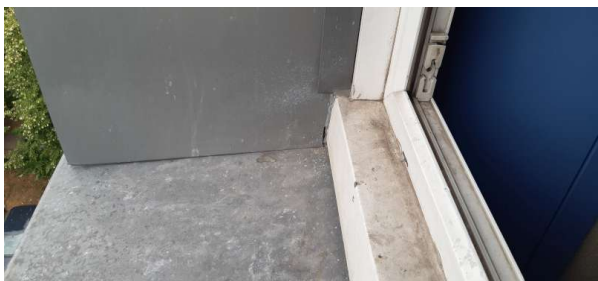
Prélèvement - P034 : Extérieur / Façades - Mastic- (Absence d'amiante)
