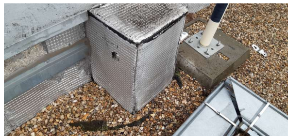
Prélèvement - P059 : Extérieur / Toiture terrasse - Relevé d'étanchéité- (Absence d'amiante)
