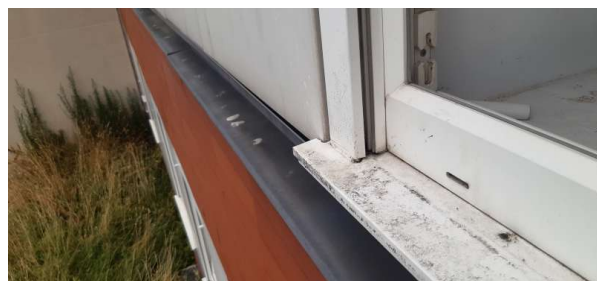
Prélèvement - P015 : Extérieur / Façades - Mastic- (Absence d'amiante)
