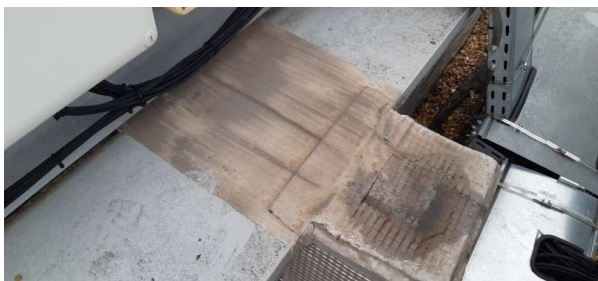
Prélèvement - P064 : Extérieur / Toiture terrasse - Mastic- (Absence d'amiante)
