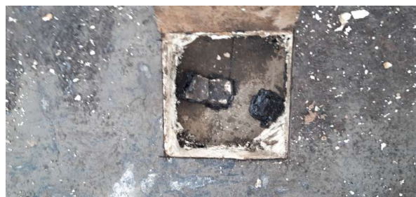
Prélèvement - P057 : Extérieur / Toiture terrasse - Pare-vapeur- (Absence d'amiante)
