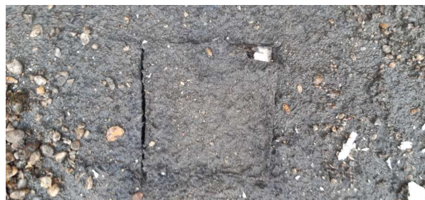
Prélèvement - P047 : Extérieur / Toiture terrasse - Revêtement d'étanchéité- (Absence d'amiante)
