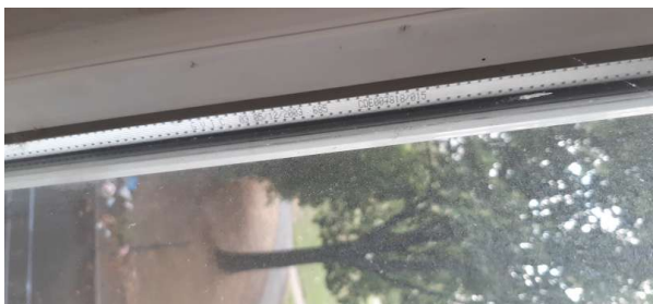
Déclaré - : R+1 / Laverie - Mastic- (Absence d'amiante)
