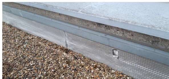
Prélèvement - P055 : Extérieur / Toiture terrasse - Relevé d'étanchéité- (Absence d'amiante)
