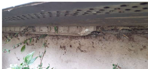
Prélèvement - P083 : Extérieur / Façades - Colle de faïence- (Absence d'amiante)
