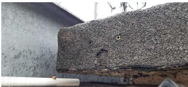
Prélèvement - P072 : Extérieur / Toiture terrasse - Revêtement d'étanchéité- (Absence d'amiante)
