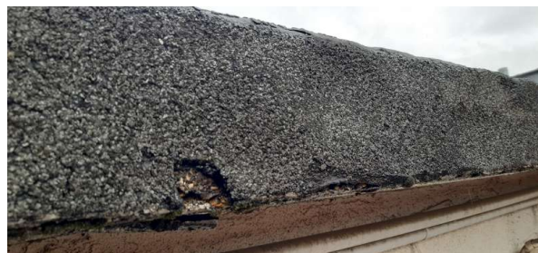
Prélèvement - P071 : Extérieur / Toiture terrasse - Revêtement d'étanchéité- (Absence d'amiante)
