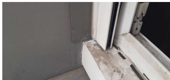
Prélèvement - P023 : Extérieur / Façades - Mastic- (Absence d'amiante)
