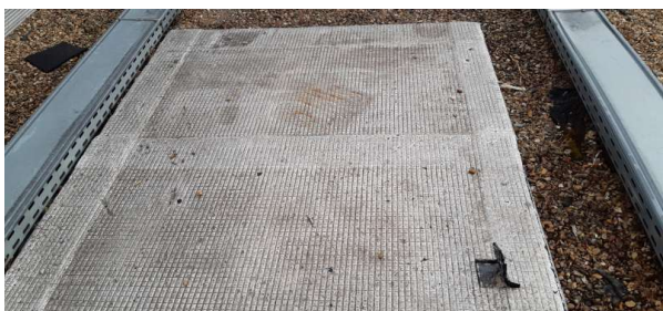
Prélèvement - P062 : Extérieur / Toiture terrasse - Relevé d'étanchéité- (Absence d'amiante)
