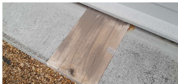
Prélèvement - P063 : Extérieur / Toiture terrasse - Mastic- (Absence d'amiante)
