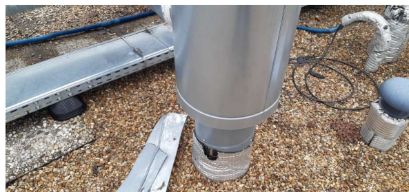
Prélèvement - P067 : Extérieur / Toiture terrasse - Relevé d'étanchéité- (Absence d'amiante)
