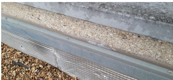
Prélèvement - P060 : Extérieur / Toiture terrasse - Mastic- (Absence d'amiante)
