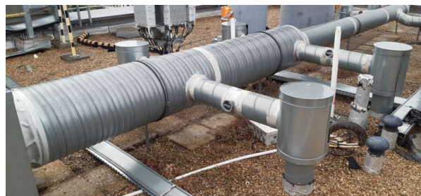
Prélèvement - P079 : Extérieur / Toiture terrasse - Mastic- (Absence d'amiante)
