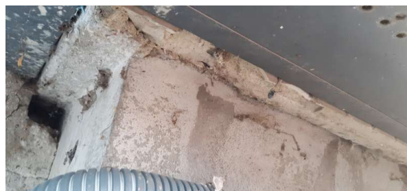
Prélèvement - P003 : Extérieur / Façades - Enduit- (Absence d'amiante)
