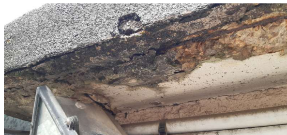
Prélèvement - P073 : Extérieur / Toiture terrasse - Sol coulé- (Absence d'amiante)
