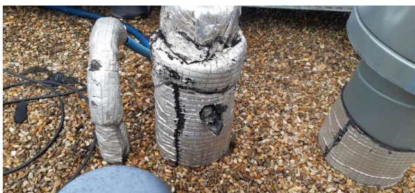
Prélèvement - P068 : Extérieur / Toiture terrasse - Conduit- (Présence d'amiante)
